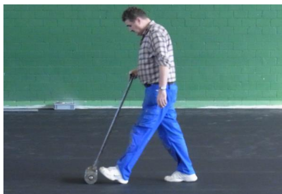
Dérouler de couche élastique à l'aide d'un rouleau de compresseur
