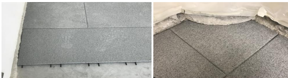
Démarrer la deuxième rangée décalée d'une demi-plaque; découper une courbe
