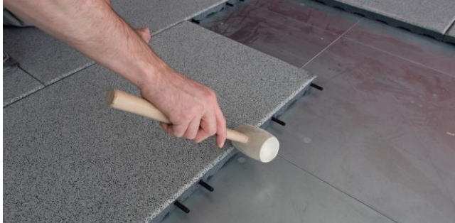
Fermez les lacunes avec un marteau en caoutchouc
