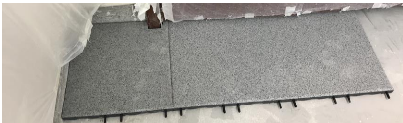
Pose des plaques le long d'un mur droit avec les connecteurs orientés vers l'avant
