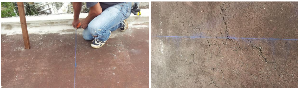
Création de lignes de craie comme aide à la pose et pose le long de cette ligne
